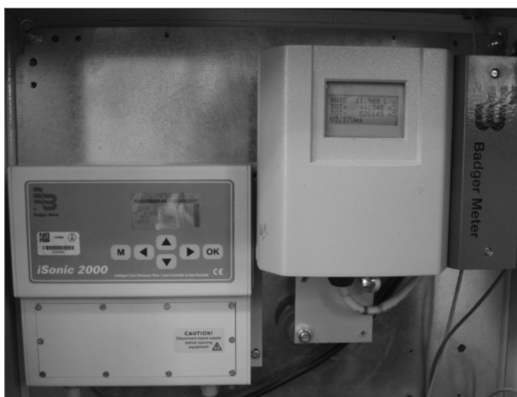
Figura 5. Instalación de sensores de nivel en los Tanques de Regulación.
