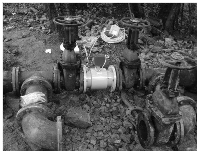
Figura 4. Instalación de medidores electromagnéticos en Sectores Hidráulicos
